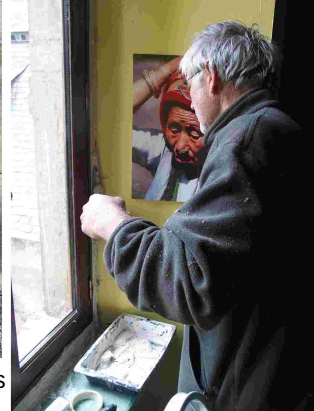
Lasure sur les huisseries et les volets les plus abîmés. Enduit au plâtre autour des fenêtres
